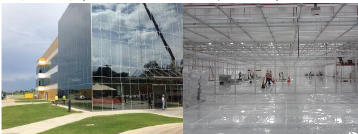
Figura 2 - Fachada da Planta e Sala Limpa (Abril/2015)
